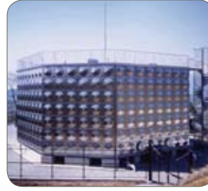
भागत ग्रेड एस यू एस 444 में, फिनिश नं 4, जे एस एस ए, जापान
